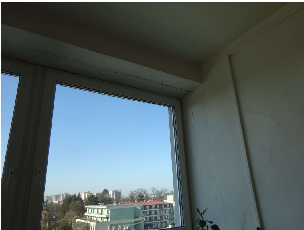
Trhliny v západní štítové stěně budovy školy
