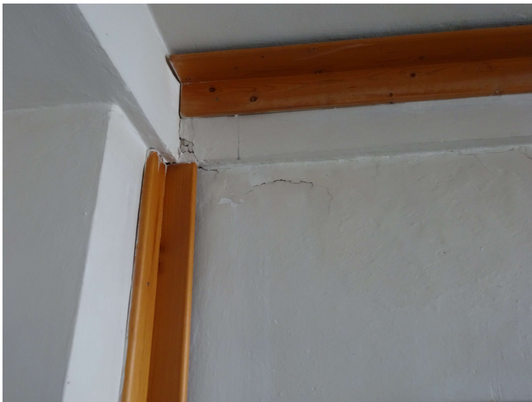
Detail trhliny u sloupu
