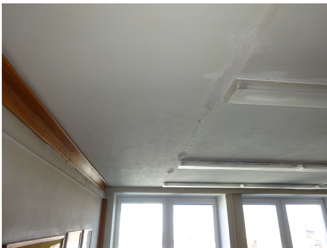
Trhlina u stropního panelu přiléhajícího ke štítové stěně
